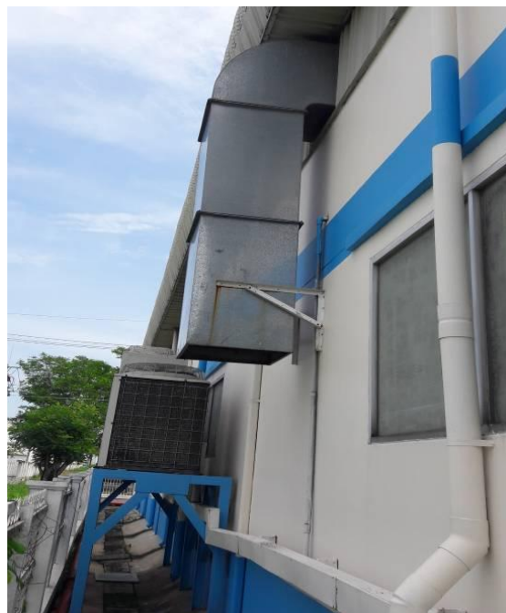
Hình 3.9. Hình ảnh minh họa các vị trí lắp đặt ống thu khí và hình ảnh ống thoát khí thải tại nhà máy 1
