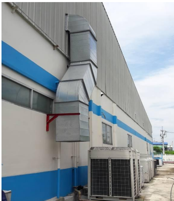
Hình 3.9. Hình ảnh minh họa các vị trí lắp đặt ống thu khí và hình ảnh ống thoát khí thải tại nhà máy 1
